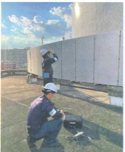
▲目視だけでなくドローンも活用して診断を行う
